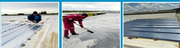
MANTENIMIENTO DE LA SEDE DEL MAGACOLEGIO CONSISTENTE EN LA IMPERMEABILIZACIÓN DE LA CUBIERTA, TECHOS, AZOTEAS Y CANALES PLUVIALES (10) AULAS DE CLASE EN EL SEGUNDO PISO, BAÑOS Y SALA DE INFORMÁTICA, CAMBIO DE TECHOS (LAMINA GALVANIZADA)
