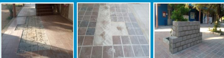
MANTENIMIENTO: SALA INGLES Y PLAZOLETA: MANTENIMIENTO DE LA SEDE DEL MEGACOLEGIO CONSISTENTE EN DESMONTAR, REEMPLAZAR, DEMOLER PLANTILLA, REMOCION DE ESCOMBROS, APLICAR PIEDRA CHINA EN PASILLO CERCA DE ESCALERA EN EL SEGUNDO PISO, EN LA SALA DE INGLES(ANTIGUA) Y PLAZOLETA DEL AREA ADMINISTRATIVA
